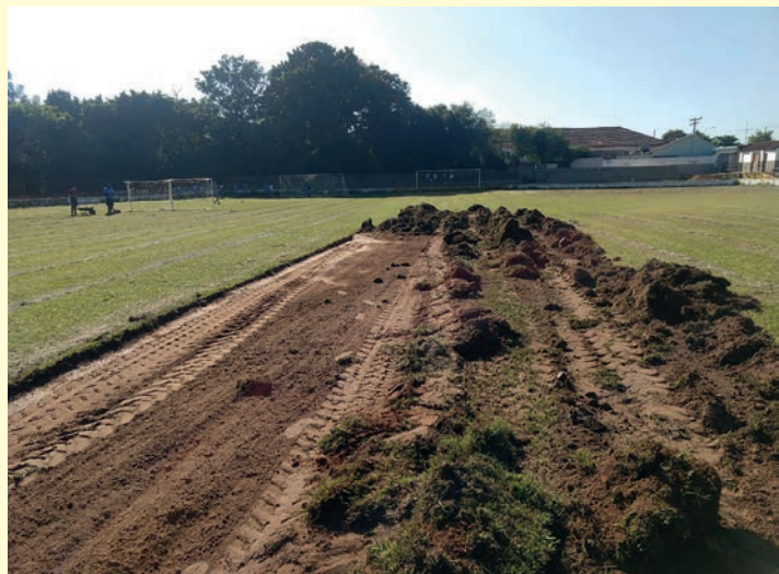
Obras já começaram no Fernando de Marco (Foto: Divulgação/Pref. de Capivari)
