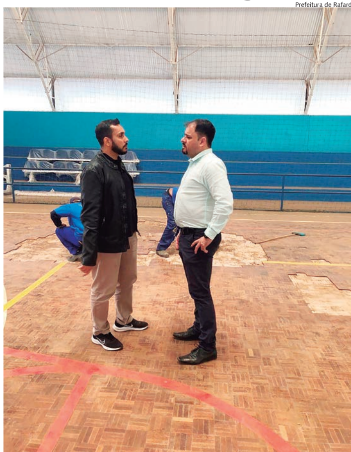
Luis Henrique e Fabinho acompanham início das obras
