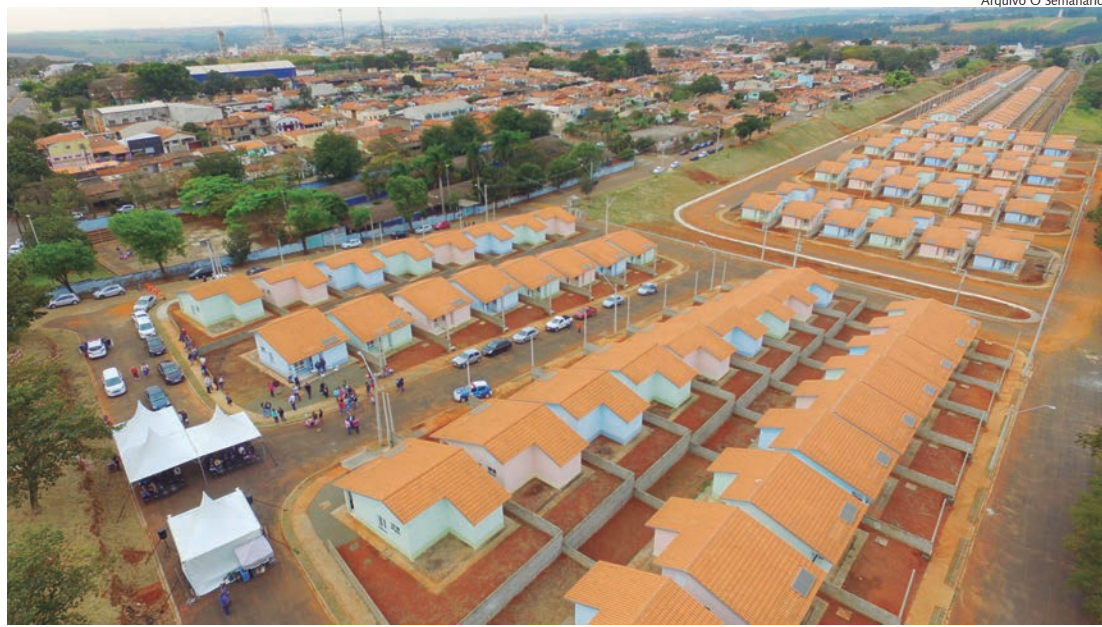
76 moradias serão beneficiadas com perfuração de poço e construção de reservatório no bairro
