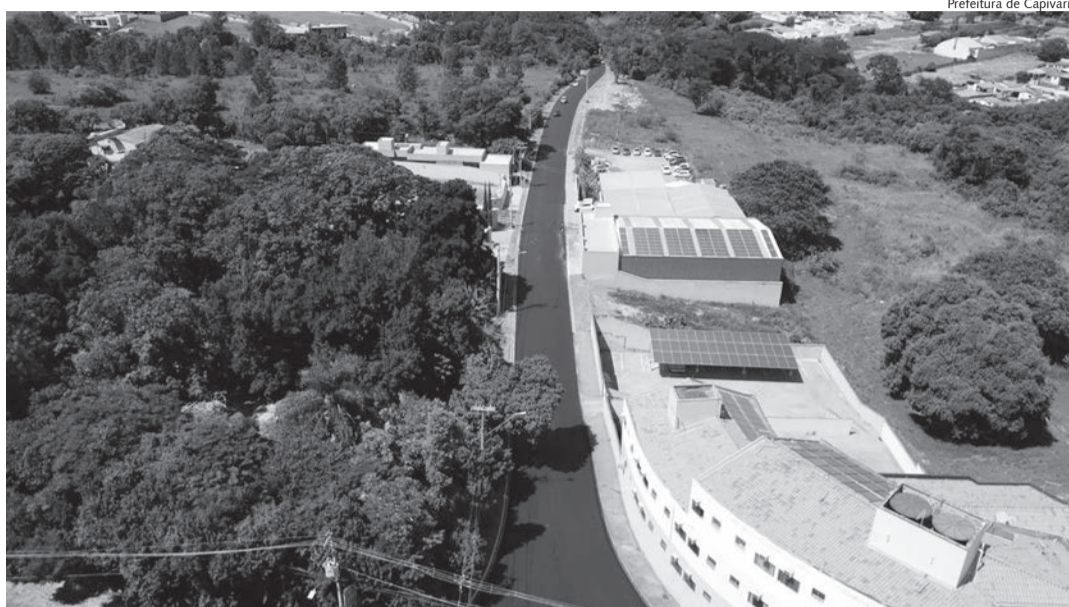
Obras incluirão construção de calçadas, iluminação em LED e ciclofaixas
