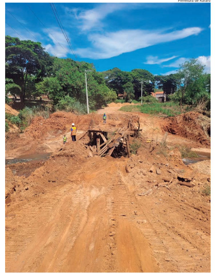
Construção de nova ponte custará cerca de R$ 1.7 milhão
